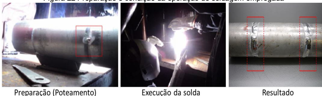
Figura 22 Preparação e condição da operação de soldagem empregada
