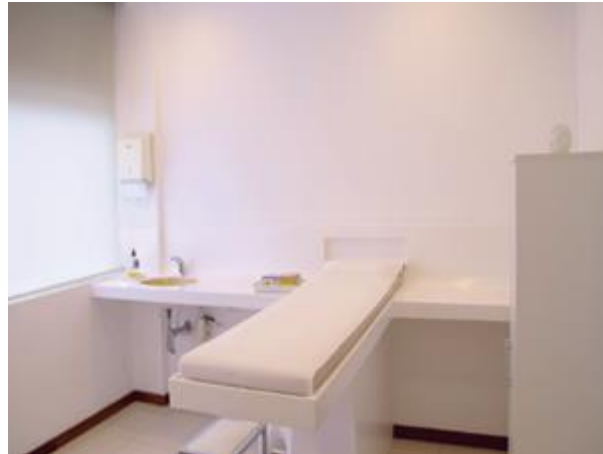
Figura 53: Parede de quarto hospitalar pintada com tinta epóxi
