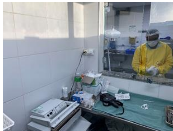
Figura 31: Janela de comunicação entre área de desinfecção química e sala suja e bancada em aço inox
