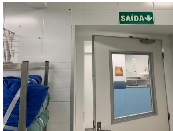
Figura 35: Entrada da Sala de Preparo
