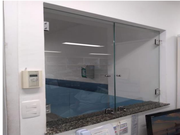
Figura 42: Janela de acesso entre recepção e área de distribuição
