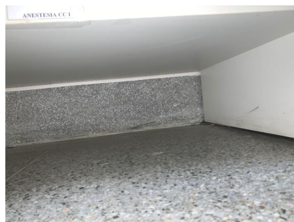
Figura 22: Rodapés abaixo de armários
