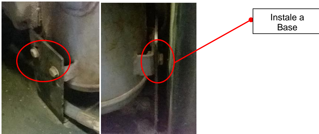
Figura 9 – Sustentação Elemento Separador. Fonte: Elaborado pelo autor (2015)
